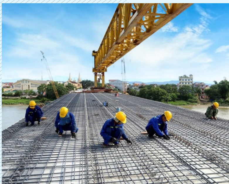
Cầu Thọ Tường (Hà Tĩnh) Thi công xây mới
