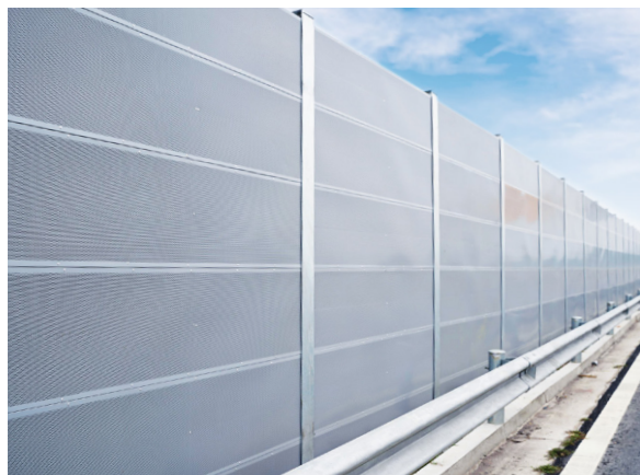
Cao tốc Quốc lộ 45 - Nghi Sơn: Sản xuất và thi công tường chống ồn tiêu âm
