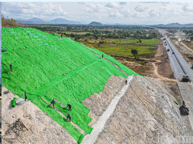
Cao tốc Vĩnh Hảo - Phan Thiết Thi công giải pháp chống đá lở, đá rơi
