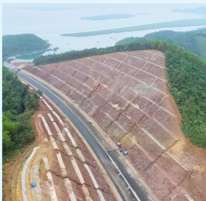
Dự án Vân Đồn - Tiên Yên Thi công giải pháp chống đá lở, đá rơi
