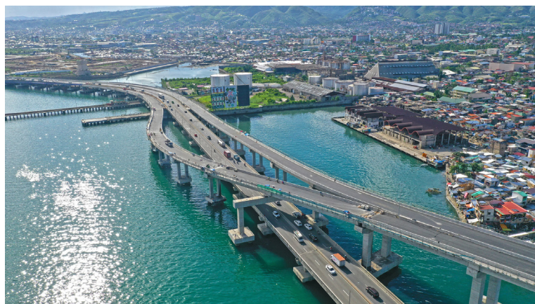
Cầu vượt biển dài nhất Philippines Cebu-Cordova Link Expressway: Sản xuất và cung cấp tường chống ồn tiêu âm
