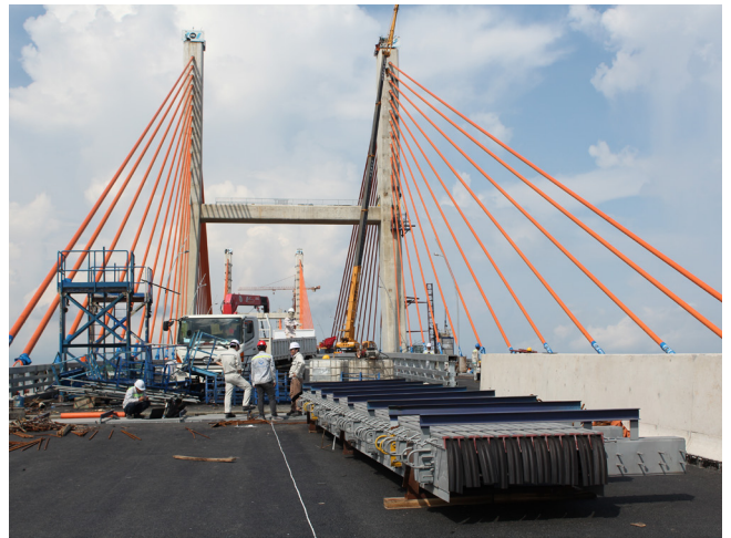
Cầu Bạch Đằng: Lắp đặt khe Mô đun
