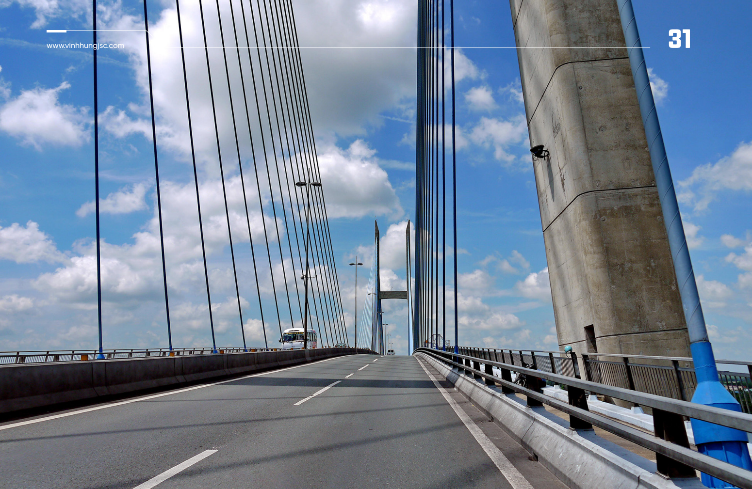
Cầu Mỹ Thuận (Tiền Giang, Vĩnh Long) Thi công sửa chữa và thay thế khe co giãn
