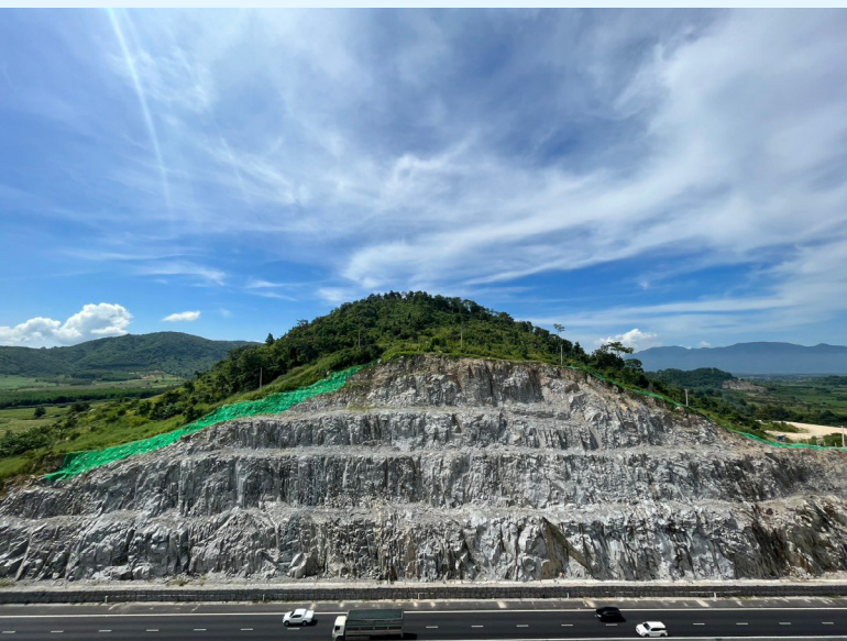
Cao tốc Phan Thiết - Dầu Giây Thi công giải pháp chống đá lở, đá rơi
