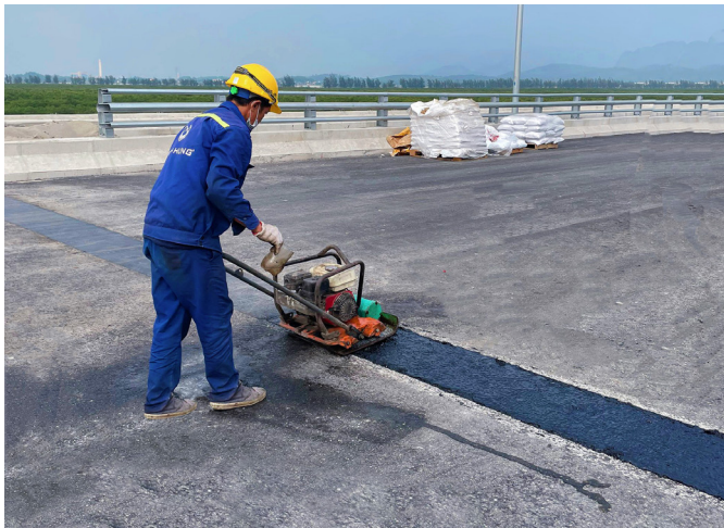
Cầu Cửa Lục: Thi công lắp đặt khe FEBA
