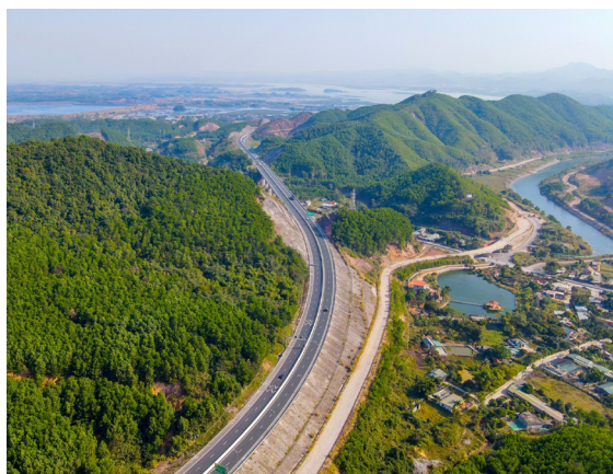
Cao tốc Hạ Long - Vân Đồn: Sản xuất và thi công tường chống ồn tiêu âm
