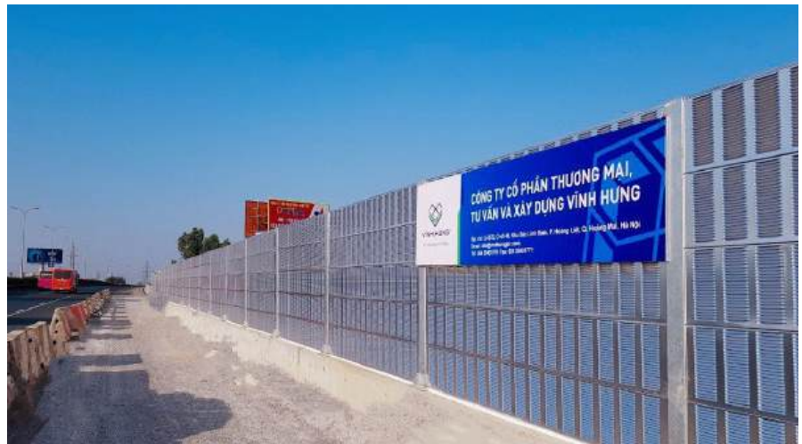
1. Phap Van - Cau Gie expressway
