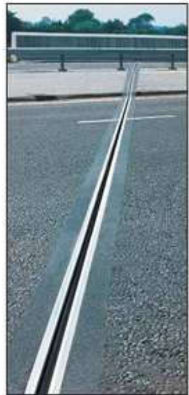
Phần đường xe chạy được lắp đặt với hệ thống BEJ.
