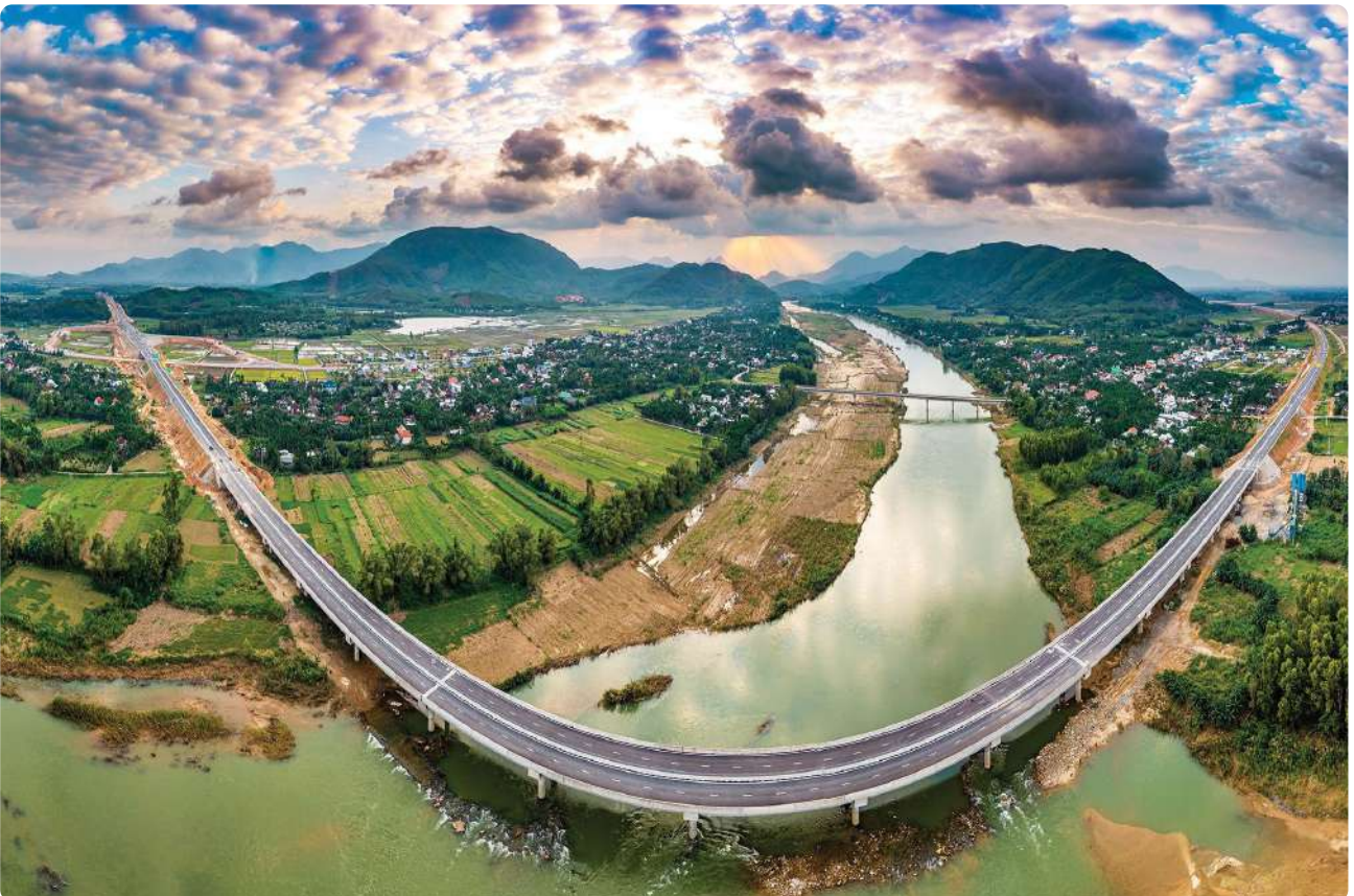
Khe co giãn răng lực VHF được lắp đặt trên toàn tuyến cao tốc Quảng Ngãi - Hoài Nhơn
