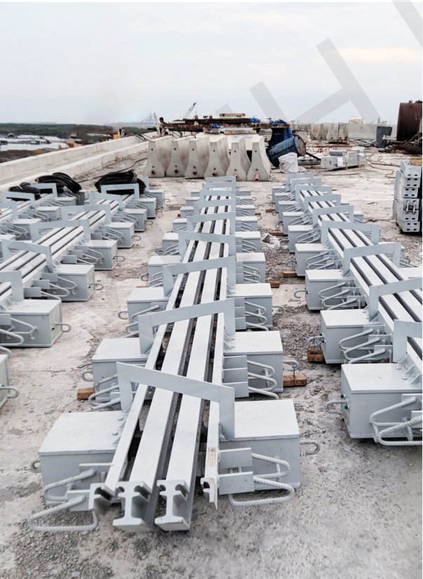
Thi công lắp đặt Khe co giãn mô đơn VHM tại Dự án cầu Mỏ Nhát (Bà Rịa - Vũng Tàu)
